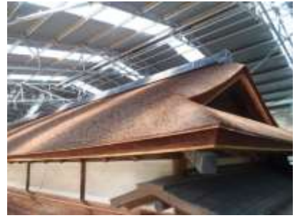
白雲邸の桧皮葺屋根の葺き替えが完成した時の様子。
