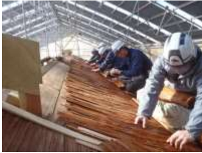
桧の樹皮をきれいに並べ、竹製の釘で打ち止めます。
