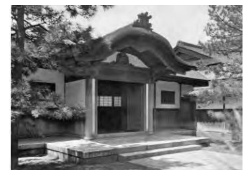
玄関棟正面側。戦災で倒壊したため、現在の物は昭和の復旧修理事業時に新築されたもの。細部のデザインが異なる。
