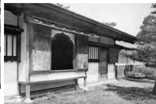
玄関棟裏側。かつては花頭窓だった。
