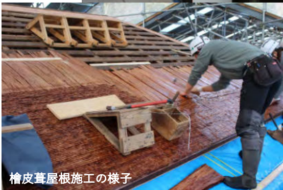
第三屋2階 檜皮葺屋根(上層)・柿葺屋根(庇)
