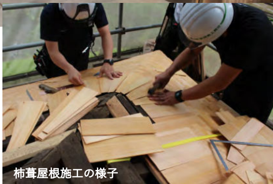
第三屋2階 檜皮葺屋根(上層)・柿葺屋根(庇)
