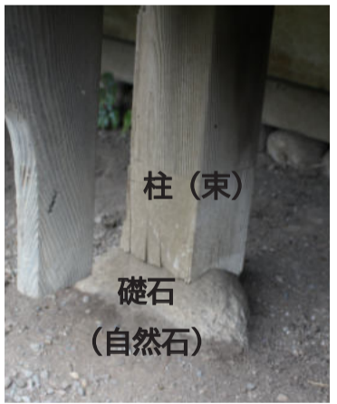
▲ 柱(束)と礎石(自然石)のひかりつけの例
