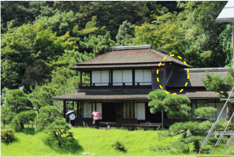
▲ せこうまえ ようす 施工前の様子 (令和元年8月31日)
