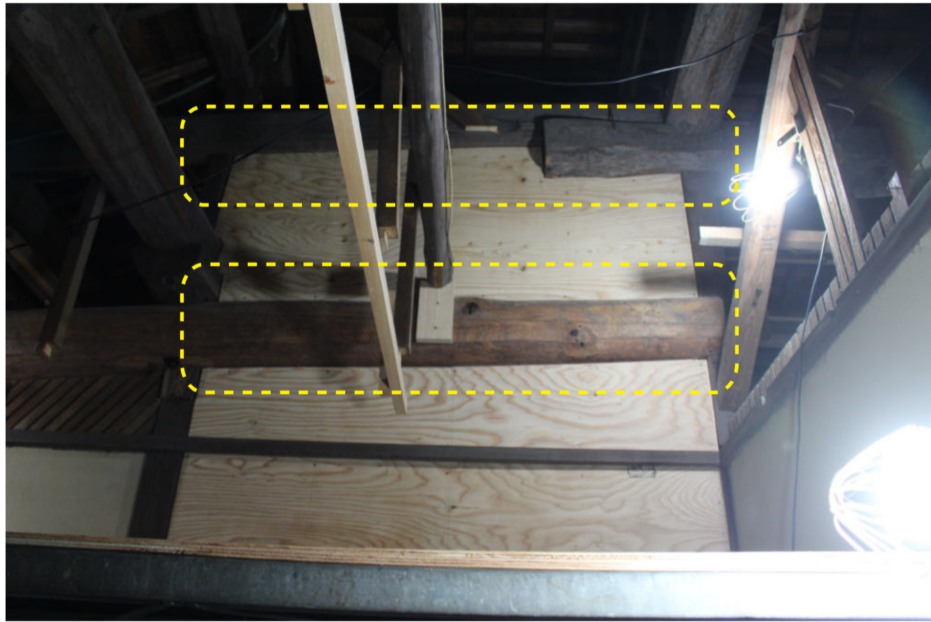
たいしんへき う あ ふせ おもし 耐震壁の浮き上がりを防ぐ重石 てつこつ てつじん (鉄骨+鉄筋コンクリート)
