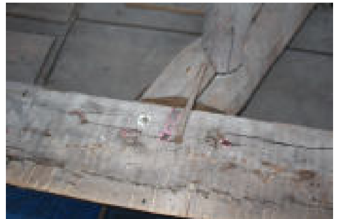
調査の様子（旧東慶寺仏殿）。建物に残された痕跡から過去の姿を探ります。
