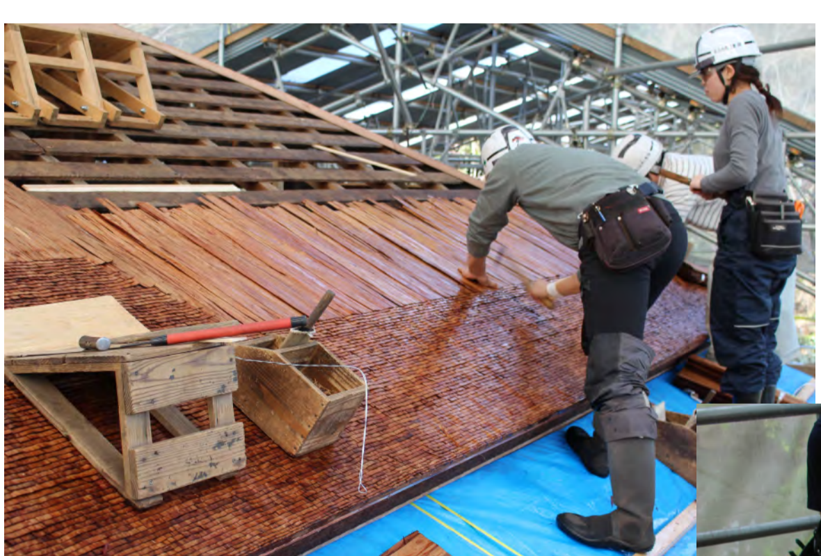
◀ 檜皮葺施工の様子（平部分） ▼ 柿葺施工の様子（隅部分）
