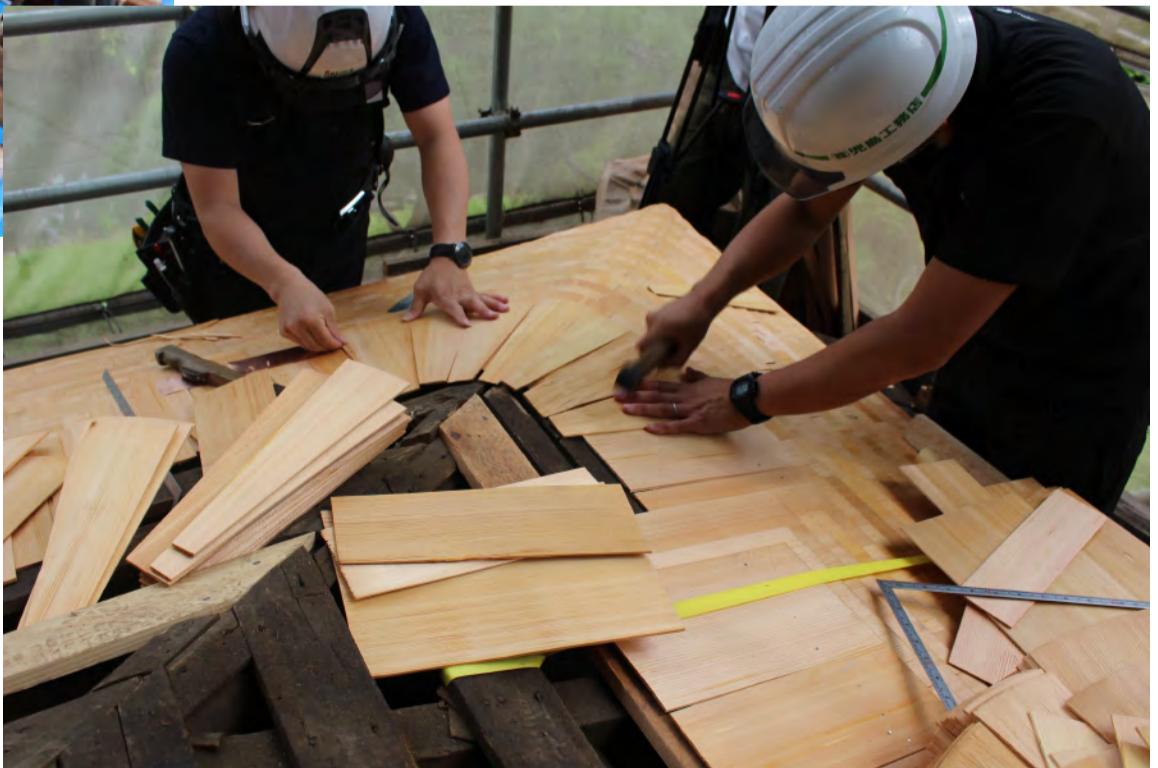
◀ 檜皮葺施工の様子（平部分） ▼ 柿葺施工の様子（隅部分）
