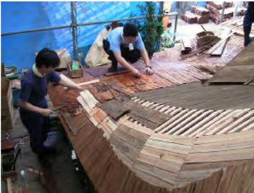
並べた<sup>ひわだ</sup> 桧皮を竹製の釘で打ち付けます。竹釘も湿らせるため、屋根葺きの職人は竹釘を口の中に含み、向きを整え口から吐き出してリズムカルに打ち付けていきます。
