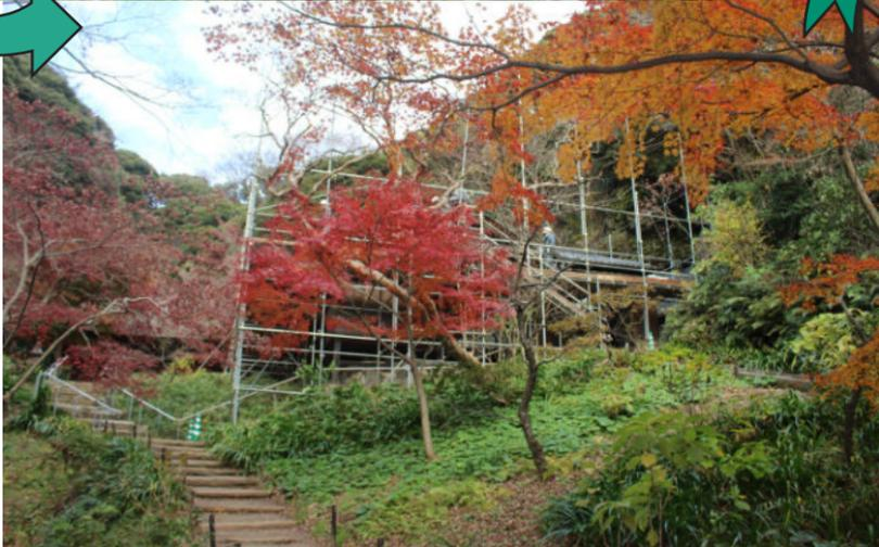
鉄のパイプを組み合わせて作り上げる「素屋根」は、仮設の建物ですが頑丈さは折り紙付き。工事中の建物を風雨から守り、適切な高さの足場によって屋根葺替工事が円滑に行えるようサポートします。
