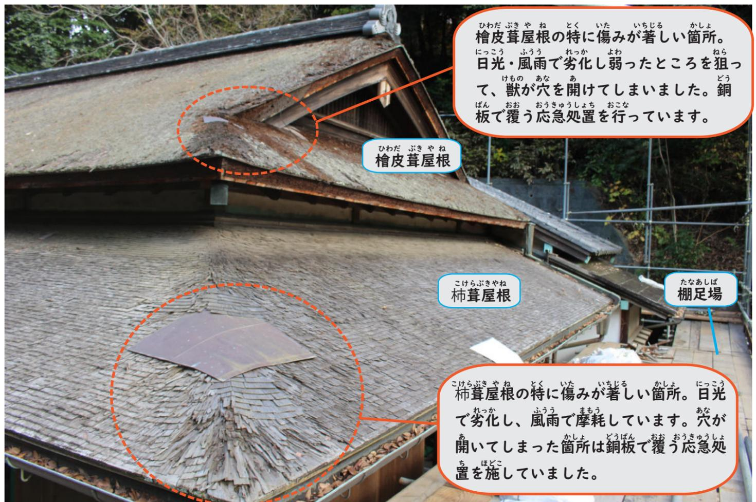
檜皮葺屋根の特に傷みが著しい箇所。日光・風雨で劣化し弱ったところを狙って、獣が穴を開けてしまいました。銅板で覆う応急処置を行っています。
