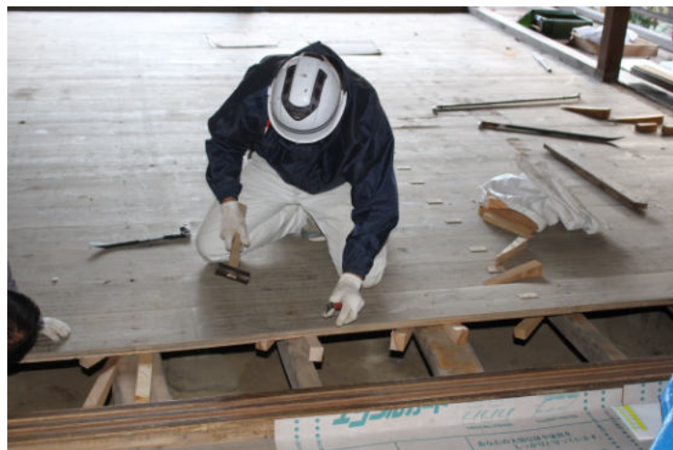
▲ 畳の下の床板の一部や敷居の一部も解体しました。
