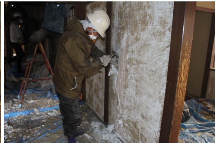
▲ 障壁画の下の漆喰壁と、その他の聚楽壁を取壊しました。壁は伝統的な「木摺壁」でした。
