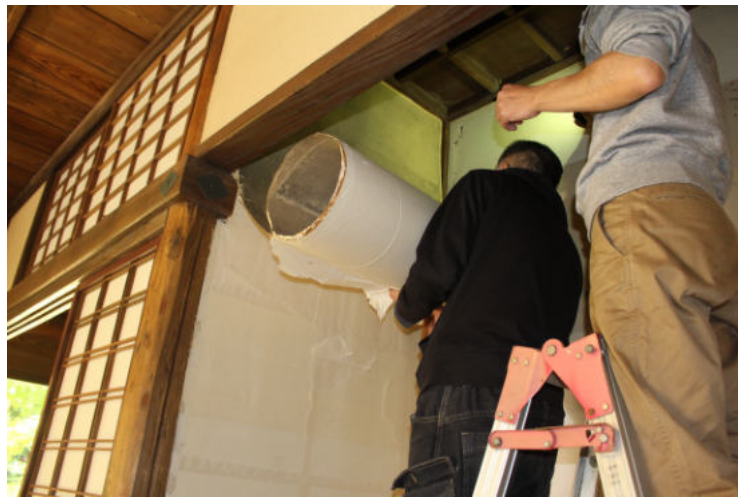
▲ 壁に貼り付けられていた障壁画は剥がして取り外しました。
