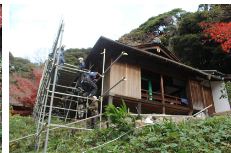
▲ 運び込んだ資材で、工事を円滑に進め、建物を守る役割も果たす「素屋根」を建設します。
