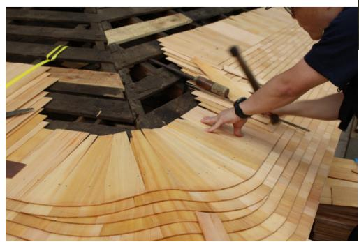
● 檜皮は草く前に水に浸し柔らかい状態にし、丁寧に並べ屋根の形を作り上げます。ながたがをってけます。ながたがをってけます。ながなた檜皮は竹製の釘で打ち付けます。たけば釘も湿らせるため、屋根をあえば、竹釘を中に含み、向きを整え口いさい。吐き出してリズミカルに打ち付けていきます。
