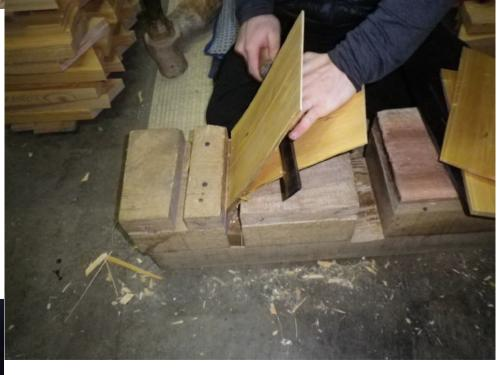
■ 柿板も檜皮同様少しずつずらして並べて を ね かたち つく あ たけせい くぎ で す な かたち つく あ をけせい くぎ で 打ち付 屋根の形を作り上げ、竹製の釘で打ち付 けます。隅や谷の曲面部分には、緩やか に曲げられる特別な材料を用いていま いた ざいりょう す。板の材料はスギやサワラなどです。
