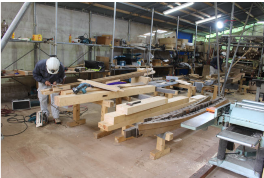
▲▶ 木負・茅負の矧木・埋木作業。傷んだ部分だけを丁寧に取り除き、適切に形を合わせた新材に改めています。
