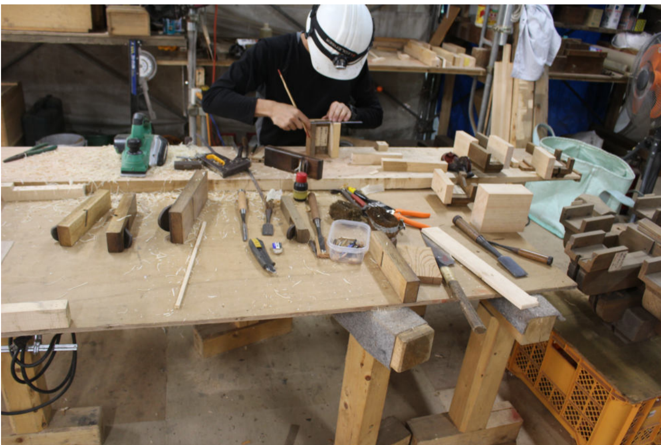
▲▶ 斗拱の矧木・埋木作業。傷み具合に応じた補修作業を行っており、場合によっては全体取り替えるもの（＝新材加工）もあります。多数ある斗拱をひたすら、黙々と繕う作業。根気、丁寧さ、集中力が求められます。
