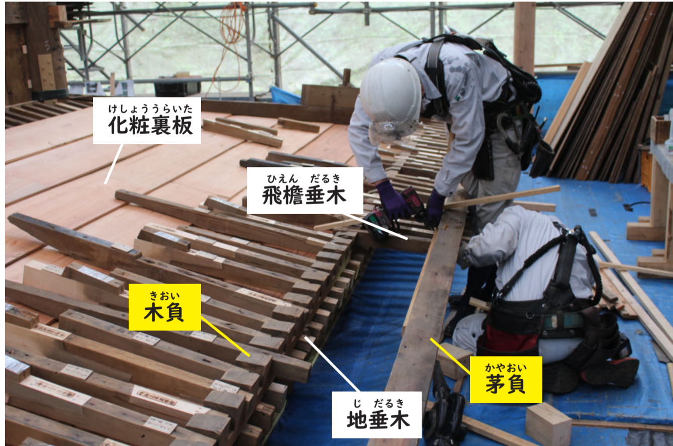
▲▶ 木負・茅負の矧木・埋木作業。傷んだ部分だけを丁寧に取り除き、適切に形を合わせた新材に改めています。
