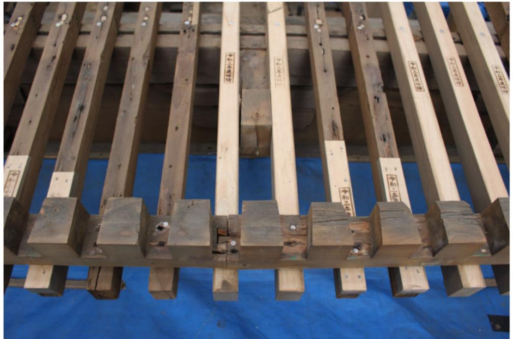
裳階隅木の矧木。傷みの著しい部分だけを新しい材料で作り直し、古い部材をなるべく残す手法。修理後に隠れる部分の色はそのままにし、見える部分には古い部材に馴染むよう「古色」をしている。
