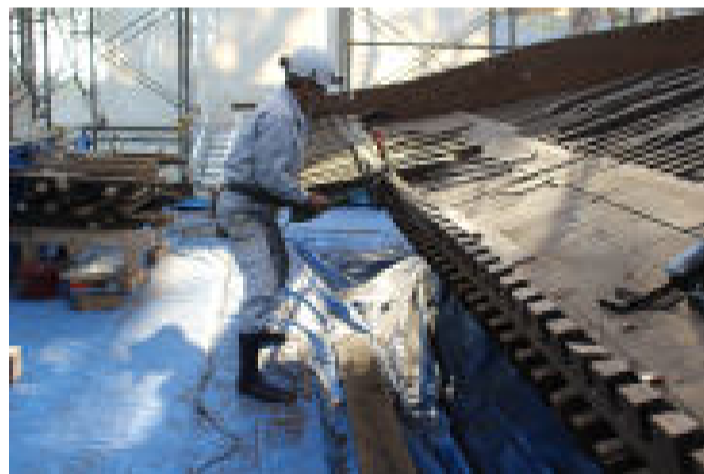
たるき かいたい ようす と はず さぎょう 垂木解体の様子。取り外し作業は、まず ばんづけいた ぶざい ばしょ しめ と 番付板(部材の場所を示すもの)を取り つけ ざい いた しんちょう とりはず 材を傷めないように慎重に取外し おこな を行います。
