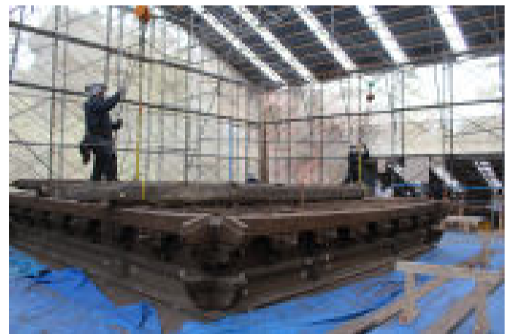
こやぐみないさいだい ざいりょう おおばりかいたい いどう 小屋組内最大の材料、大梁解体・移動の さぎょう おも ざいりょう 作業。とても重たい材料なので、チェー ンブロック*をつか うんぱん を使い運搬しました。 *滑車とテコの原理を利用して、鎖で重いものを上げ下げ するための道具
