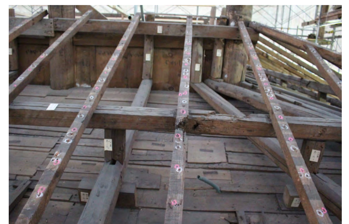
釘の跡を調べる「痕跡調査」。白が明治の移築時、赤が創建当初の痕跡。
