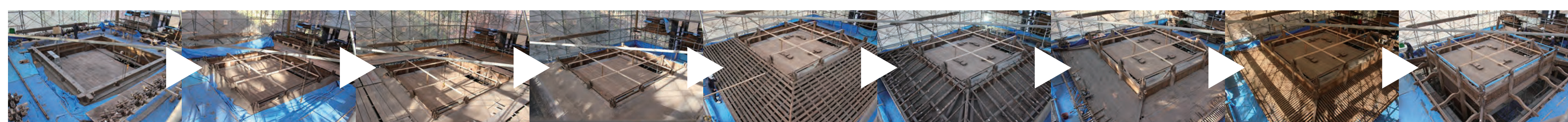
釘の跡を調べる「痕跡調査」。白が明治の移築時、赤が創建当初の痕跡。
