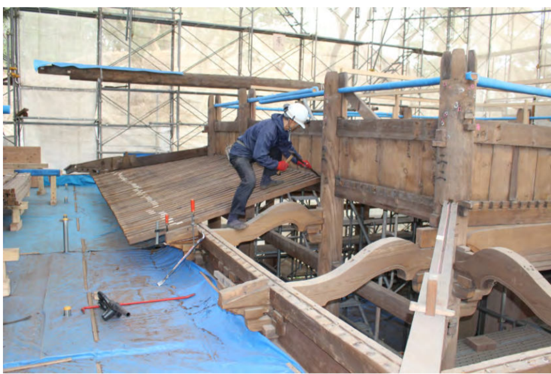
解体作業の様子。部材を傷めないように、丁寧にほどいていく。
