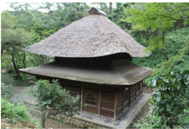
茅葺屋根・こけら葺屋根は、特に背面・側面の傷みが著しい状況です。
