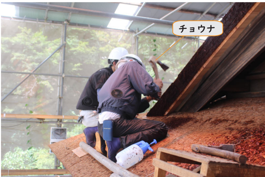
チョウナによる入母屋破風軒付けの切り揃え作業。ベテラン技術者が新米職人への指導を行っていました。
