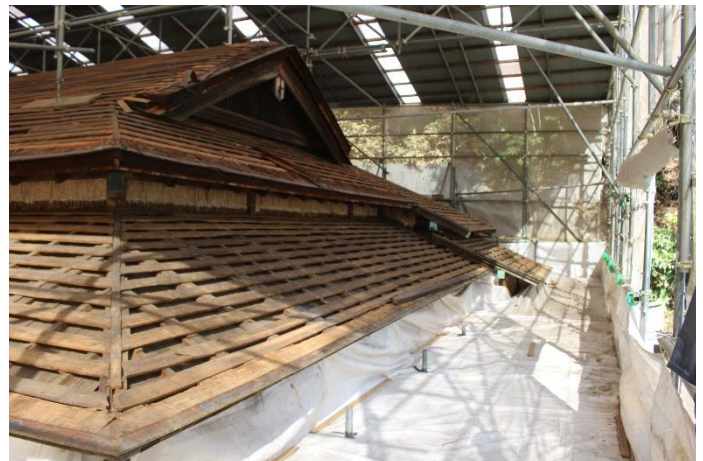
古い屋根解体後の屋根下地の様子
