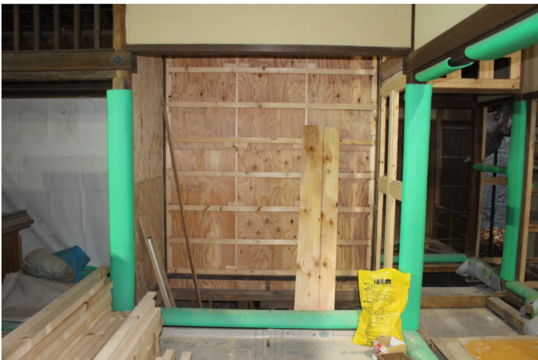
▲床の間の壁。構造用合板が張られた状態です。
