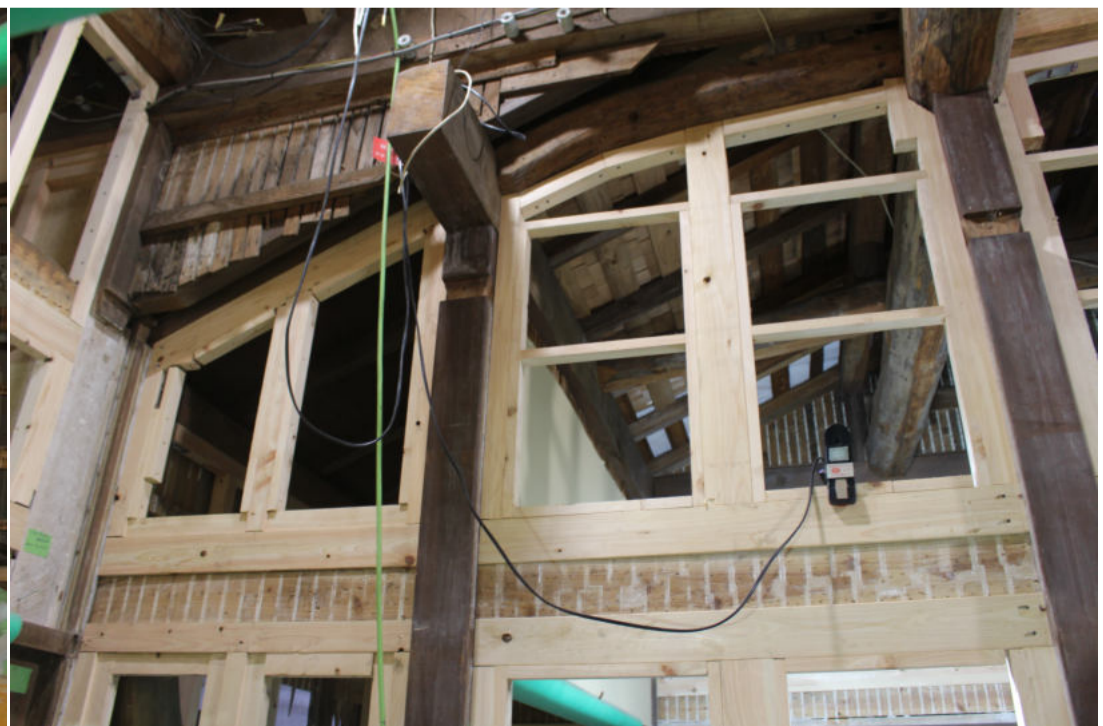
▲複雑な形状の小屋梁に合わせて、構造用合板の下地も形作られています。この上に張り付ける構造用合板も形に合わせて切ります。
