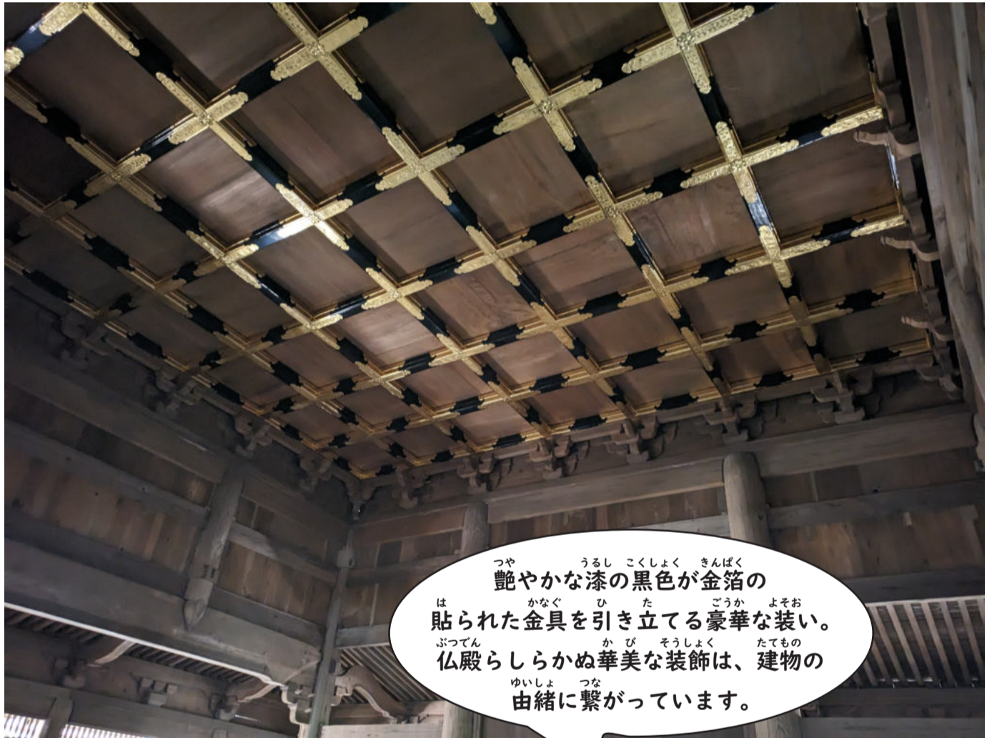
しゅうりまえ ようす れいわ がんねん ちやくしゅまえちようさ ▲修理前の様子（令和元年の着手前調査） うるし つや うしな かなぐ きんぱく は さ 漆は艶を失い、金具は金箔が剥がれ錆び ぜんたいてき ようす てしまい、全体的にくすんだ様子でした。
