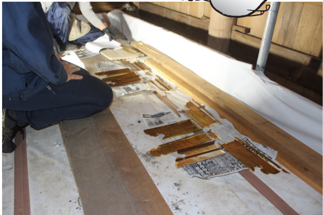
かなぐ わ もと と つ ▲金具はいくつかのパーツに分けられていて、元に取り付け いち せいかく もと かなぐ てあった位置に正確に戻されます。金具のパーツはそれぞ いち しる ふごう ばんづけ とりつけまえ なら れに位置を記した符号（番付）をもとに、取付前に並べて まちが な かくにん せいり 間違いが無いように確認整理しました。
