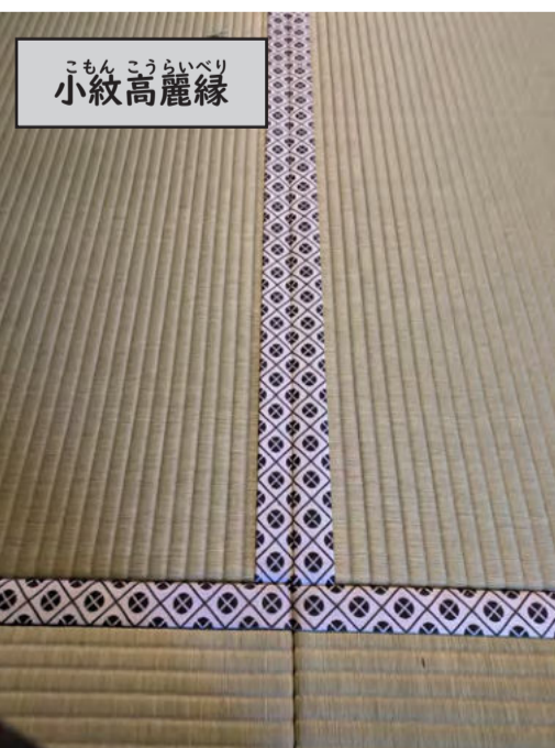
しんざい わら お かた つく わらどこ 芯材は藁をきつく押し固めて作った「藁床」。 かけぬ よ しゅほう つく こうきゅうひん 「掛縫い」と呼ばれる手法で作られた高級品。
