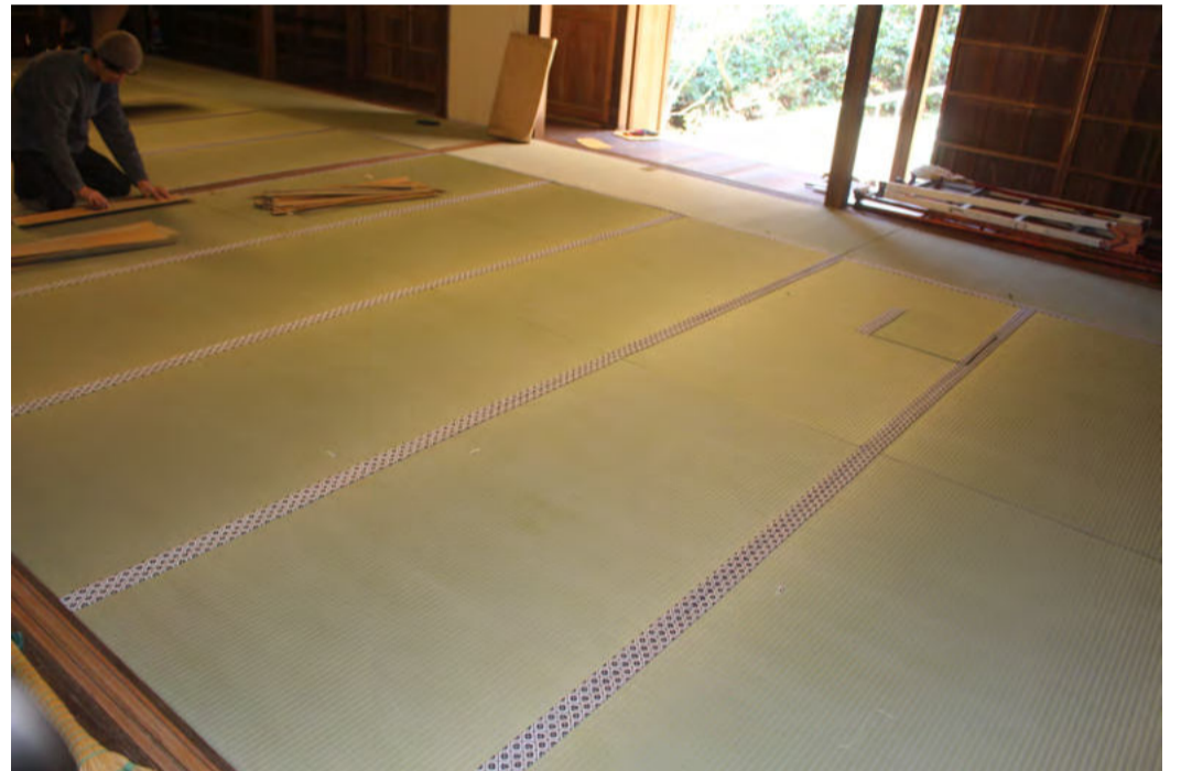
し つ じょうたい ゆか たか たたみ あつ さ 敷き詰めた状態。床の高さや畳の厚さにはわずかな差があるの たたみ した かいもの たたみおもてしょうへん たか そろ で、畳の下に飼物（畳表の小片など）をいれ、高さを揃えます。
