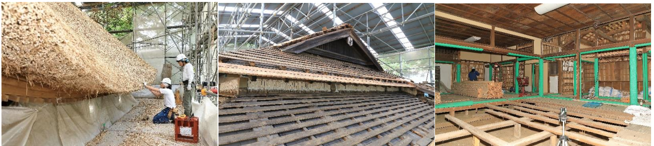
旧東慶寺仏殿 屋根葺き替え工事
