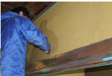
壁の表面（土壁・障壁画）は解体前同様に復旧しました。作業は伝統的な技法で行われています。
