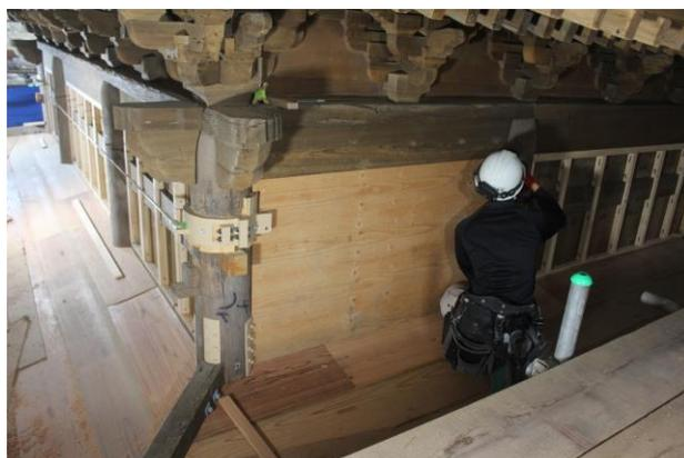
小壁耐震壁・虹梁補強金具施工状況
