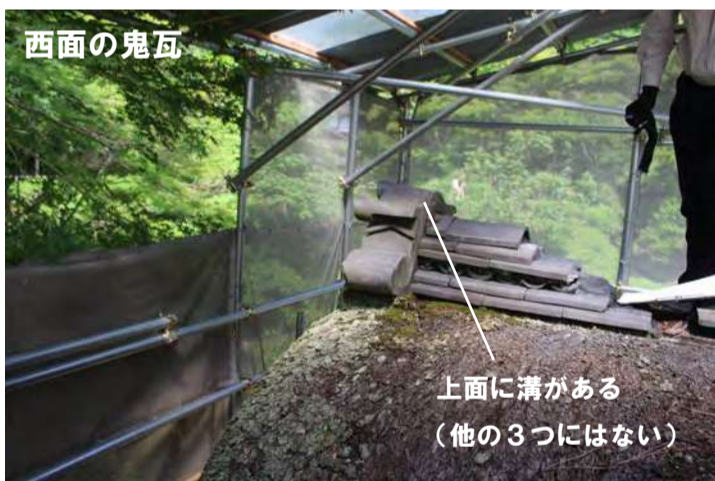
▲棟瓦の積み方を確認するため、断面構造が分かるように解体しました。
