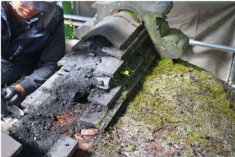
▲棟瓦の積み方を確認するため、断面構造が分かるように解体しました。
