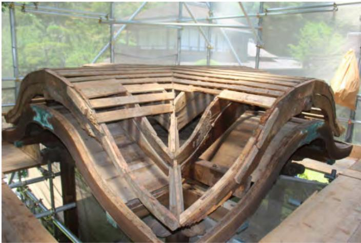
◀部材に残る加工痕から恐らく明治末～大正時代に作られたと推定。さらに垂木や隅木がすべて二段のため、屋根は本来低く設計されたのでは？と推測されました。ただし二段とも加工痕が同一なため、後からの改変ではなく、建立当初に設計変更したと推測されています。
