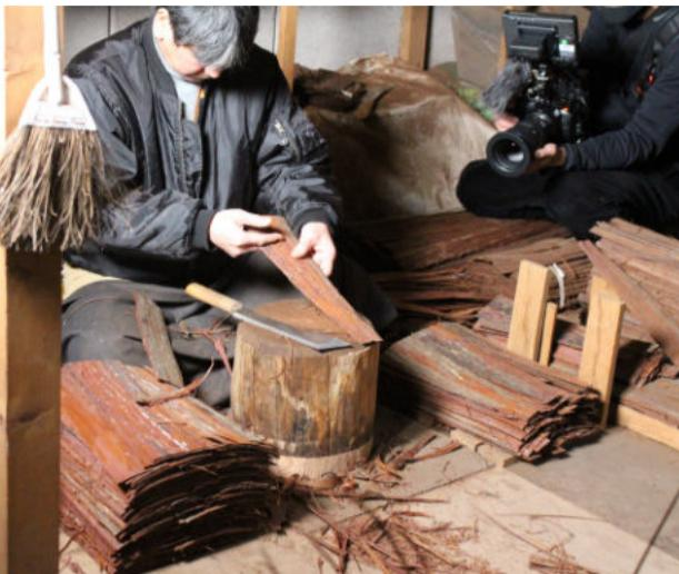
森で採集された檜の樹皮は、そのままでは大きさも厚さもバラバラで屋根葺き作業には使えないため、屋根を葺くのに適した形や厚みになるように丁寧な下ごしらえ作業を行います。この地道な作業が、現場の屋根葺き作業を支えているのです。
