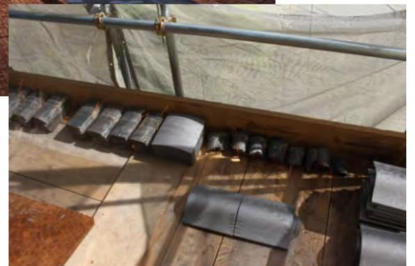
▲瓦を葺く際には「南蛮漆喰」を糊代わりかつ空隙を埋める素材として使いました。南蛮漆喰は最初は粘土状で柔らかいですが、時間が経ち乾くと硬くなります。乾燥するまでは楔などを入れて、支えて形を保ち整えます。
