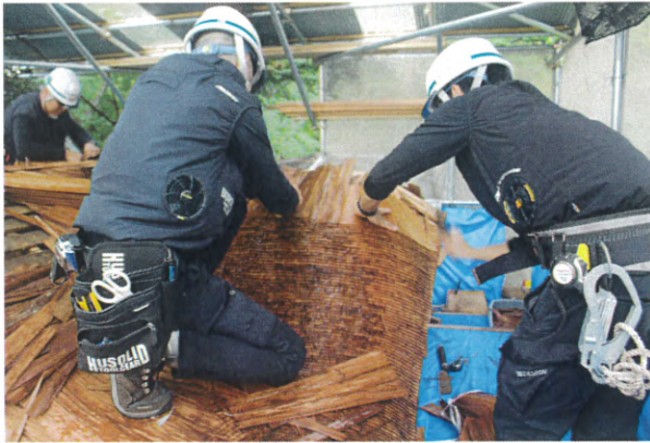
檜皮葺屋根施工状況
