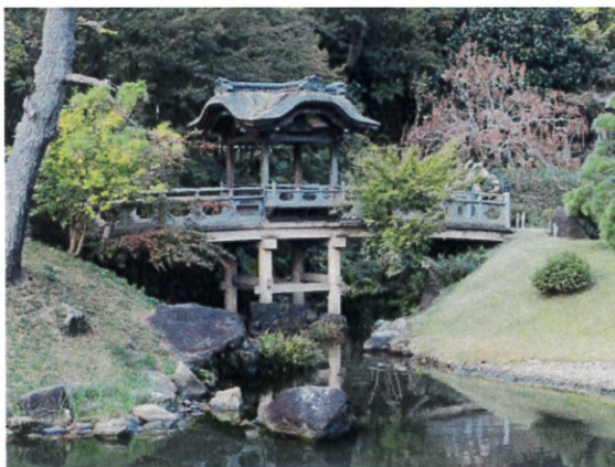
檜皮葺き屋根葺替工事 施工前
