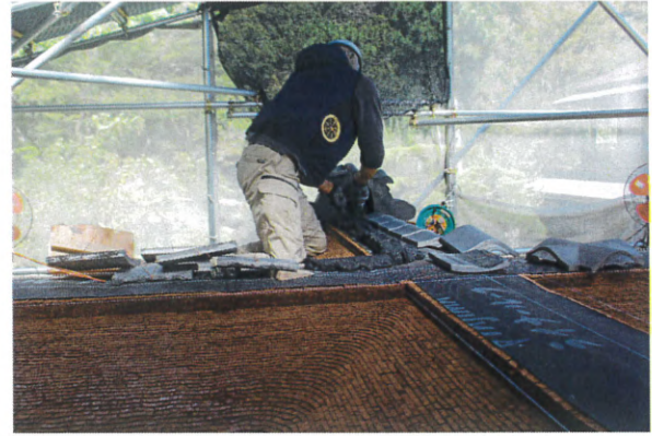
瓦棟施工状況
