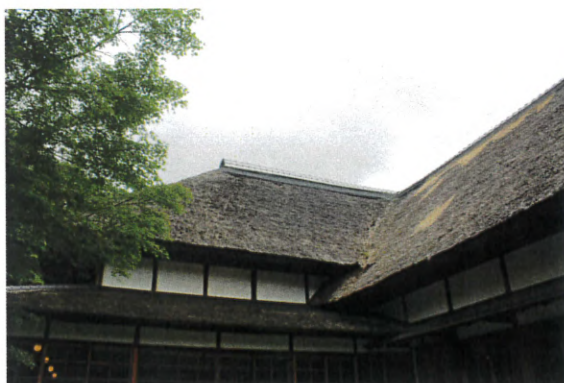
(鶴翔閣茅葺屋根差茅工事 施工前)
