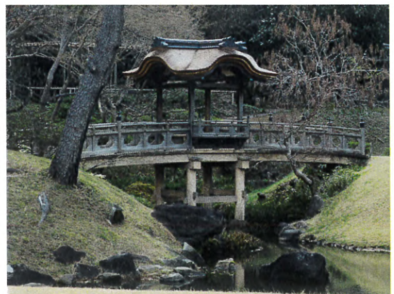
檜皮葺き屋根葺替工事 竣工後
