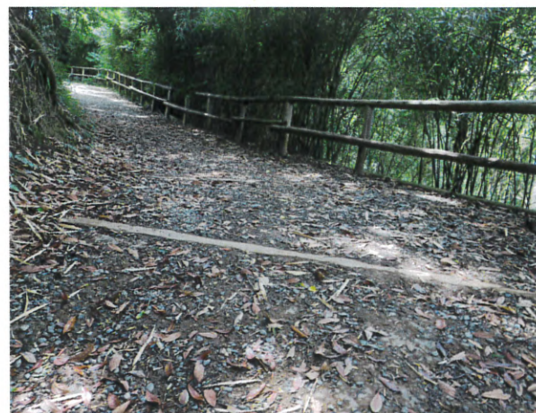
三重塔周辺園路補修（工事後）
