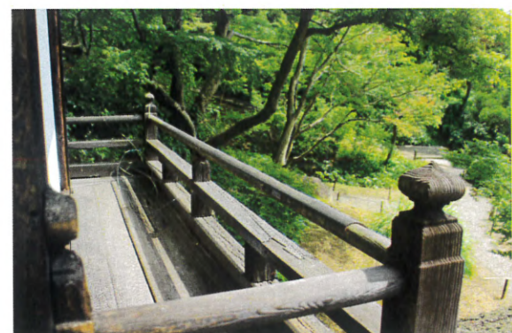
(聴秋閣木部小破箇所修繕工事 施工後)
