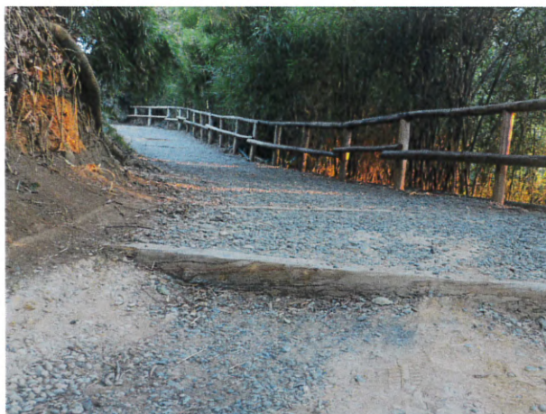
三重塔周辺園路補修（工事前）
