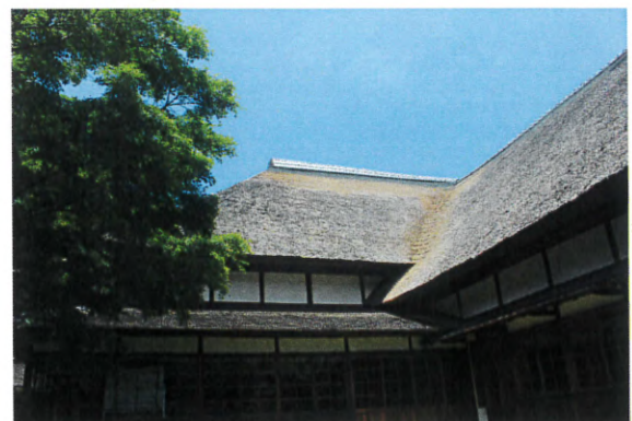
(鶴翔閣茅葺屋根差茅工事 施工後)
