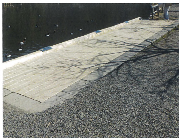
親水デッキ修理（工事後）
