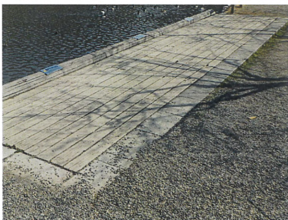
親水デッキ修理（工事前）
