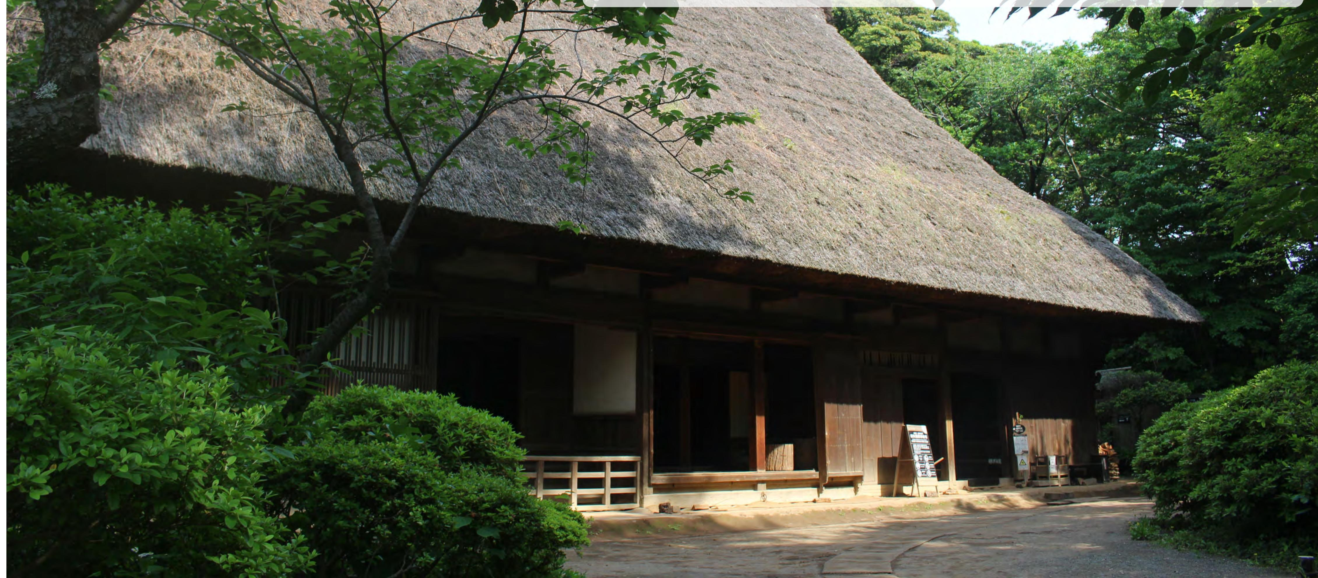
旧矢箇原家住宅では現在、保存修理のための工事が行われています。最大の目的は雨漏りするほど劣化している茅葺屋根の葺替ですが、加えて旧矢箇原家住宅は園内で唯一常時内部見学が可能な場所であり、地震から建物を守り建物を安全に利用できることが求められるため、耐震補強工事を行ってまいります。
