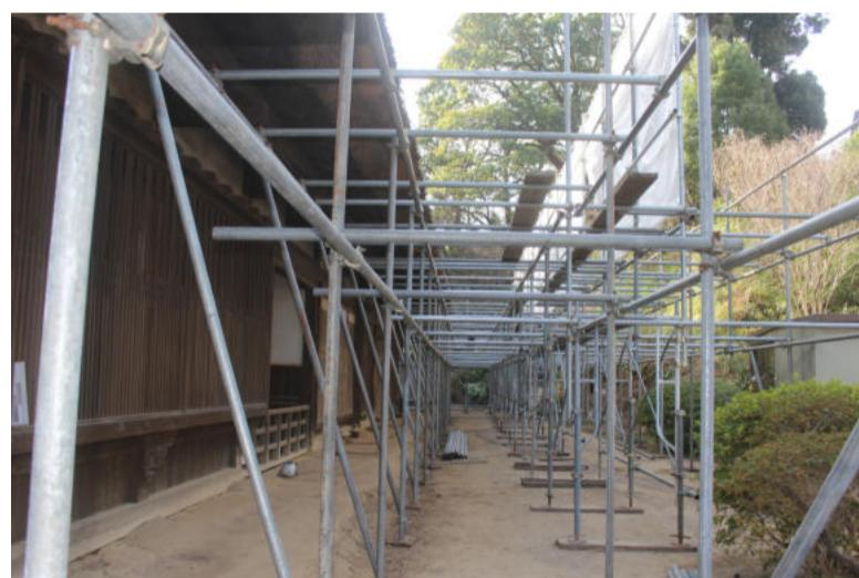
内部は鉄パイプを組み上げたジャングルジムのような様相。必要な形状に合わせ、パーツを組み上げて巨大な仮設物を造り上げていくのは熟練の技の賜物です。
