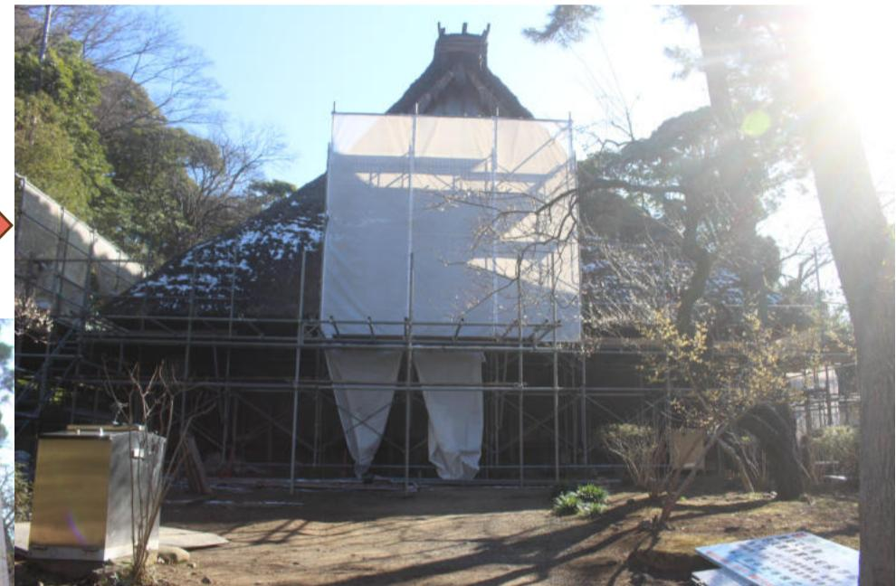
数週間であつて組みあがっていました。中央に高く設けたステージは、屋根妻側の鼻小屋の板葺き屋根葺替用の足場となります（左図参照）。
