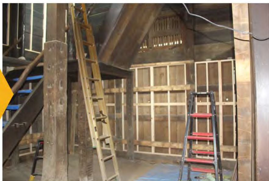
構造用合板のための下地材設置
