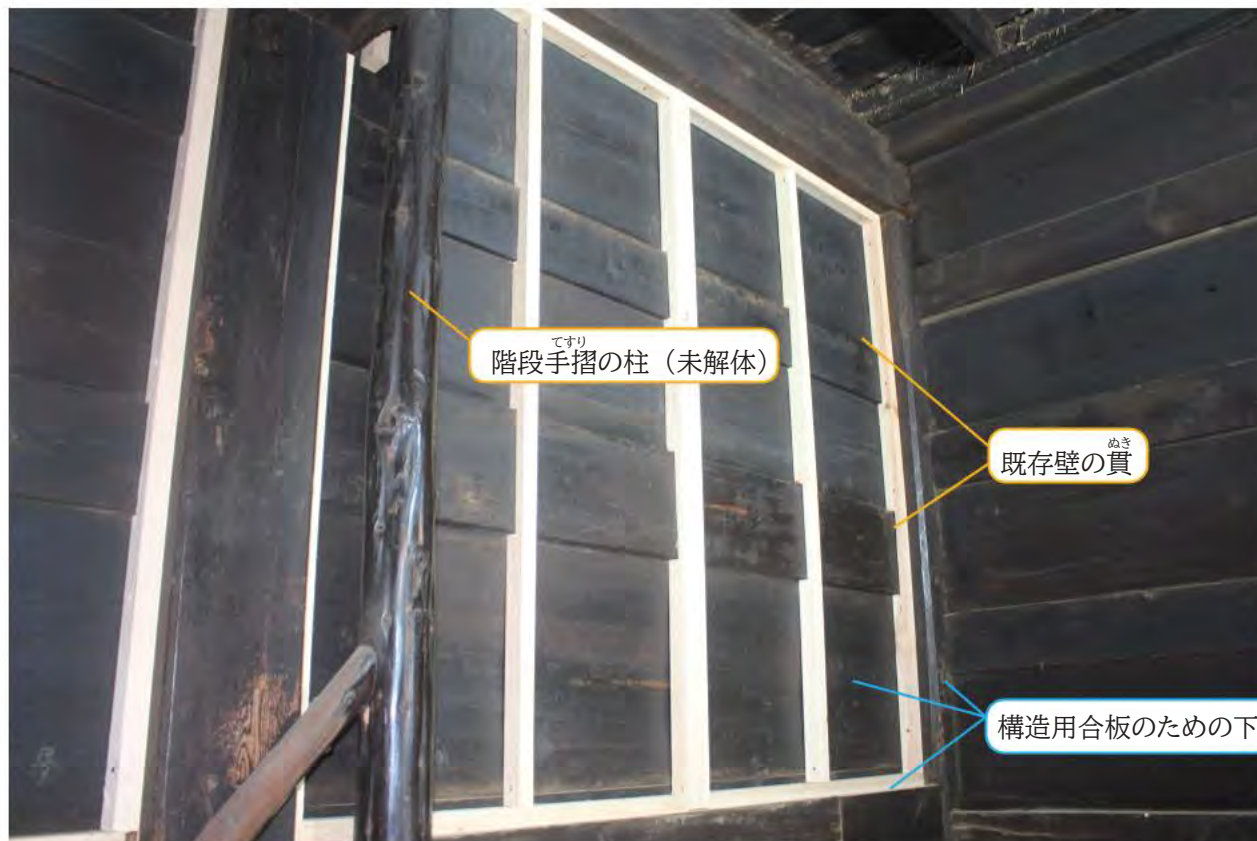
構造用合板のための下地材設置
