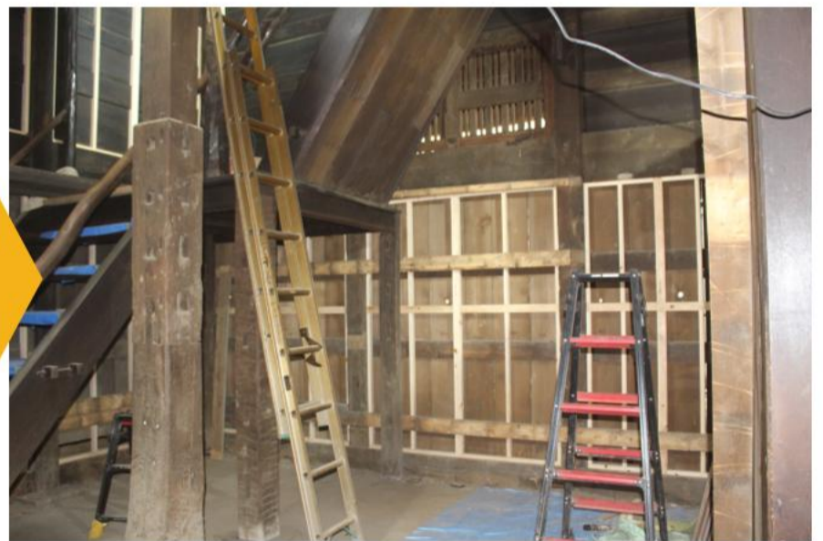
構造用合板のための下地材設置
