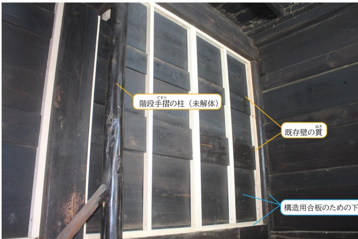
構造用合板のための下地材設置
