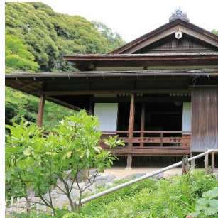
重要文化財 月華殿 徳川家康が慶長8(1603)年に京都・伏見城内に建てた諸大名の控えの間と伝えられ、京都・宇治の茶商・上林三入、同宇治の三室戸寺金蔵院の所有を経て、大正7(1918)年に三溪園に移築された。内部には伝・海北友松筆の障壁画がある。
