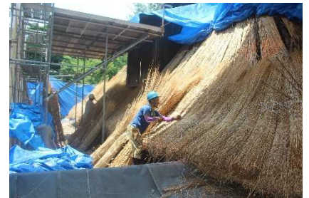
屋根葺き替え工事の様子
