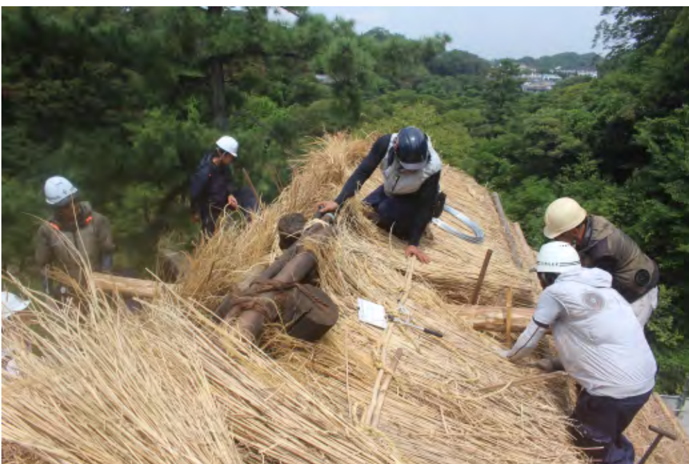
からすおど 烏踊り設置作業。位置や傾きを確認しながら、慎重に設置しました。
