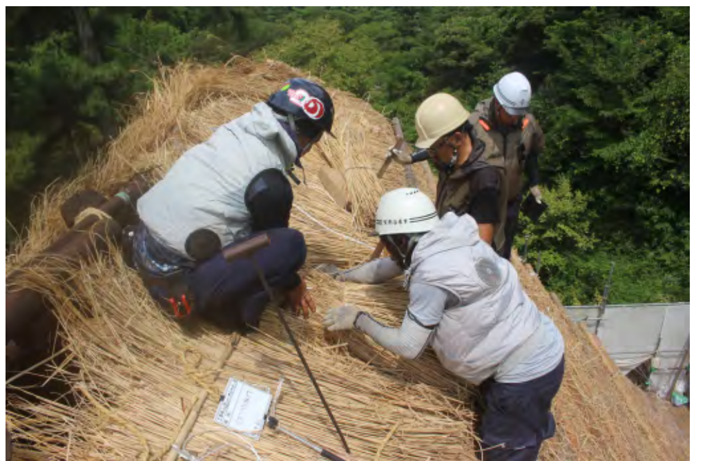
からすおど 烏踊りの周囲に茅を取り付け、烏踊りの周囲から水が入らないようにする。
