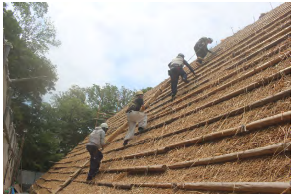
からすおど 烏踊りを屋根上まで持ち上げる作業の様子。重量があるため4人がかりで行う。
