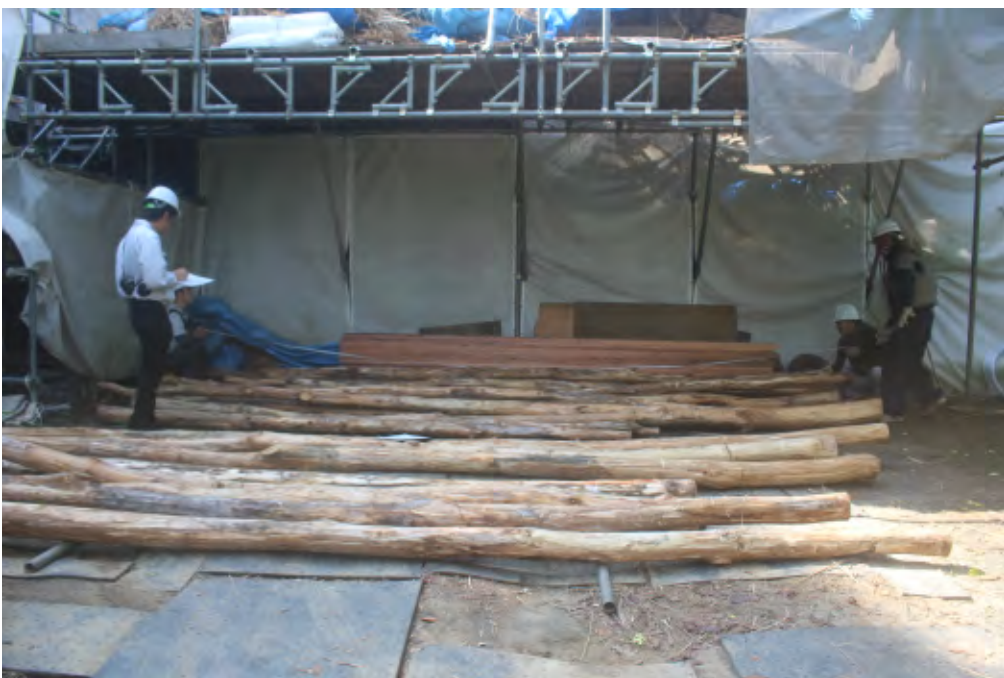
からすおど 烏踊りの材料検査、材種は栗、大きさは直径12～15cm、長さ3～3.5m。搬入した材料の状態を確認し、適切なものを使用するべく検査を行う。
