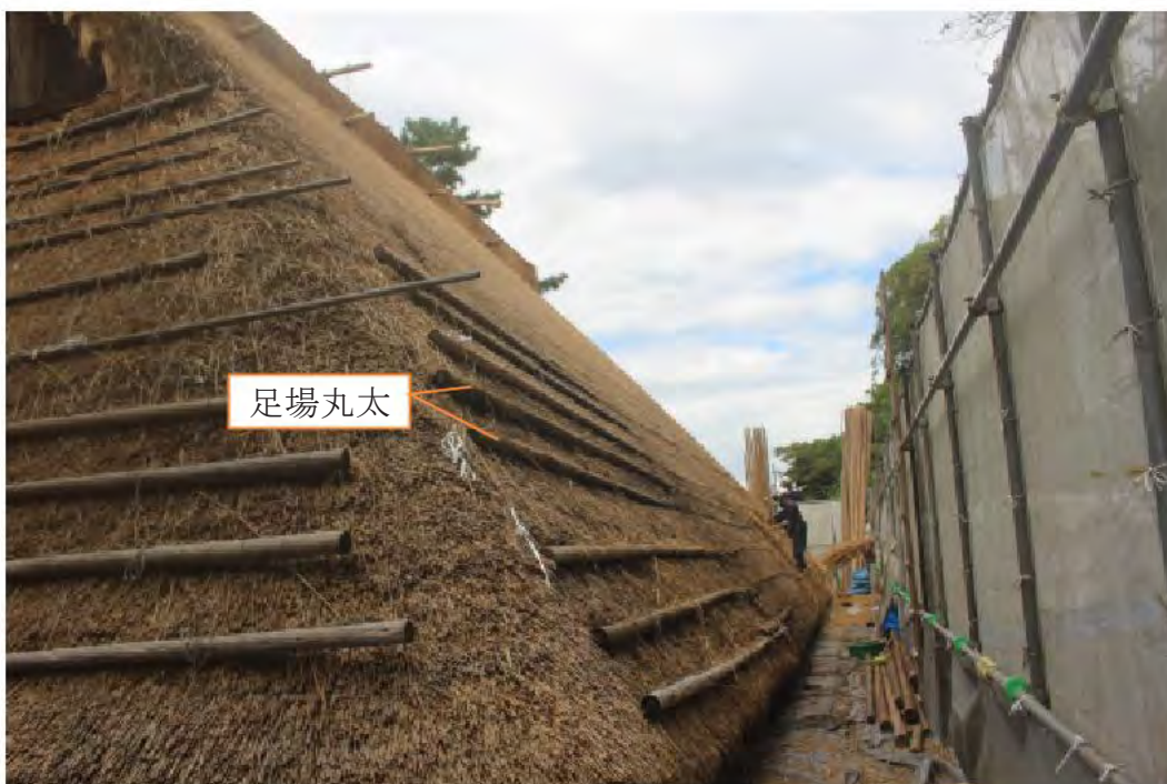
刈込作業を行いながら、上から順次足場丸太を解いて外して下りていく。
