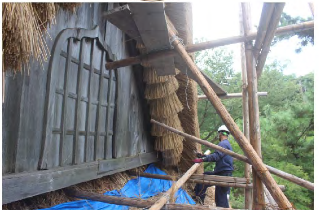
鎧茅の取付作業。ここでも小さなハサミで形を整えていく。
