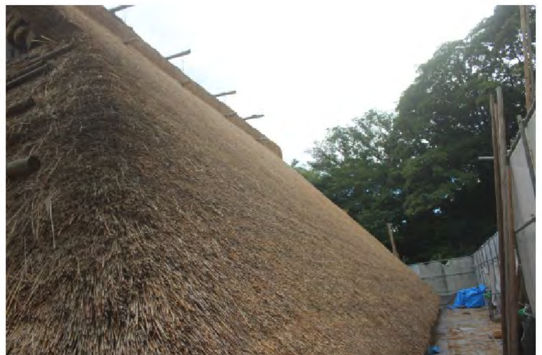
刈込、足場丸太の解体作業完了後の様子。柔らかな仕上がり。
